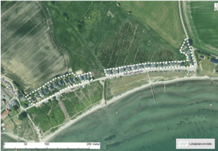
Luftfoto med lokalplanområdets afgrænsning
