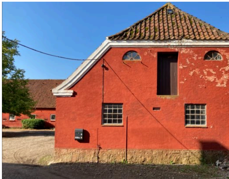
Bygning 4 " gavl - foto fra 2024
