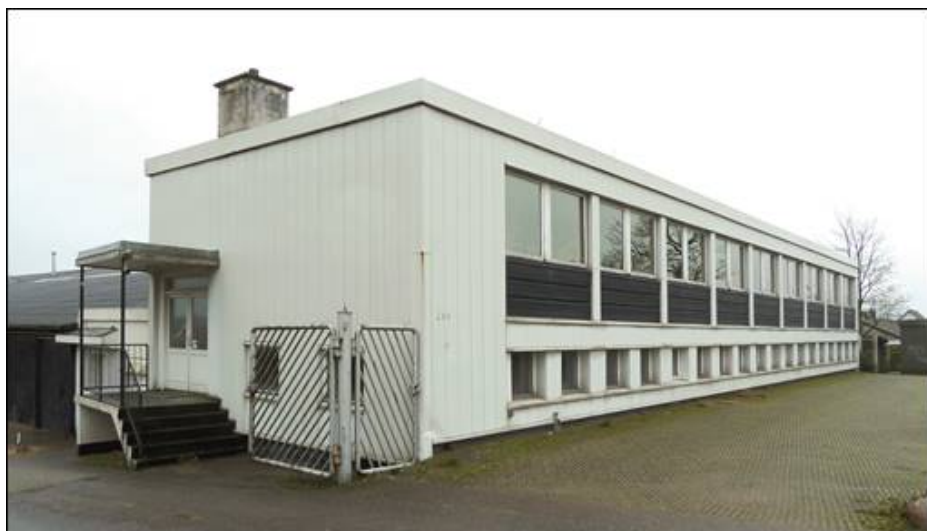
Eksisterende bebyggelse, Diesellas tidligere administrationsbygning.
