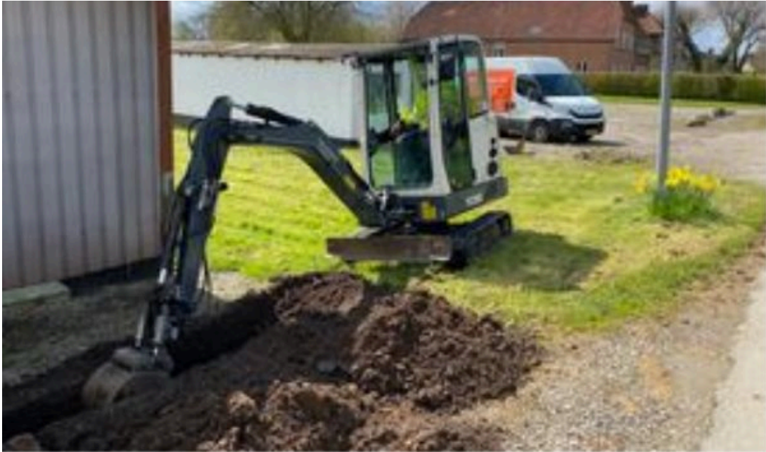
Her ses gravearbejdet i forbindelse med indlæggelse af strøm i huset bag gravemaskinen.
