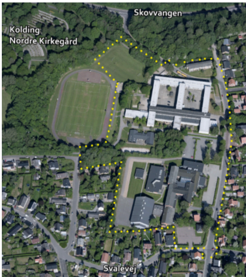
Skråfoto mod øst af planområdet ved Dyrehavevej. Gul prikramme er fremtidig afgrænsning af rammeområde 0115.O1.
