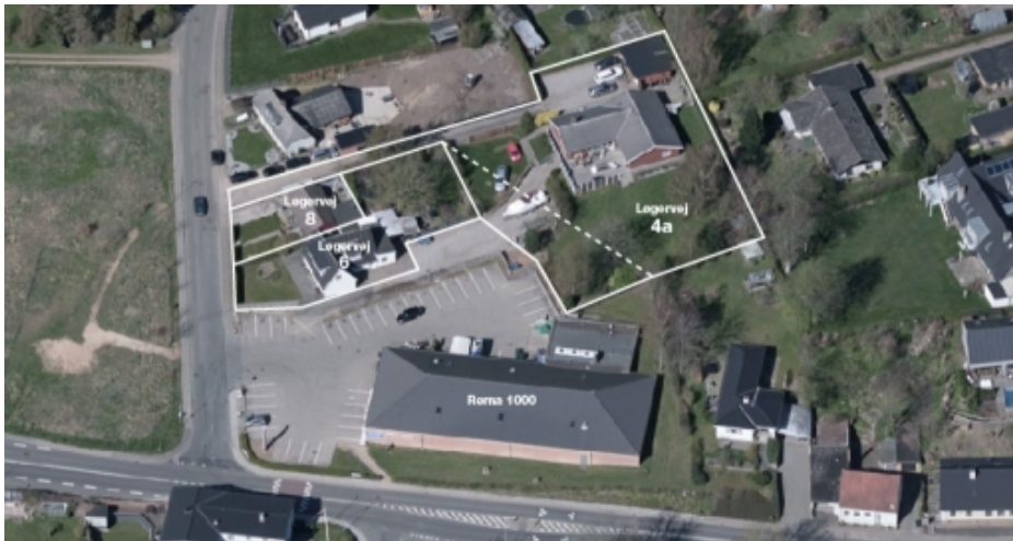
Skråfoto med markering af ejendommene Løgervej 6, 8 og 4a.
