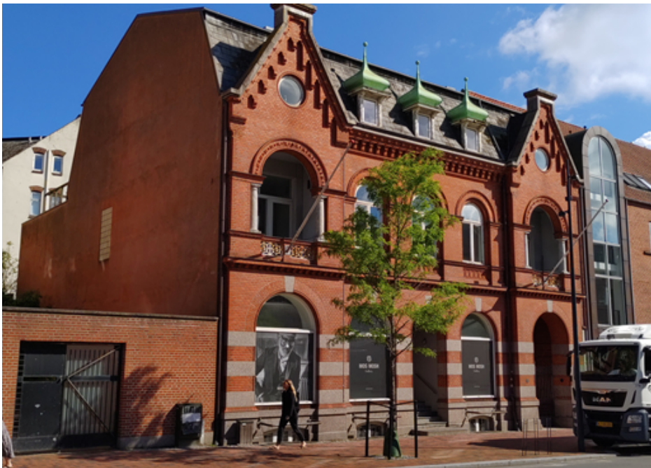
Ejendommen Jernbanegade 29, Kolding i dag.
