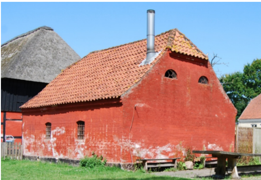
Bygning 15. Foto fra 2019.
