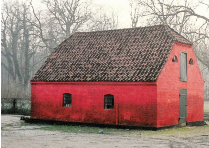
Bygning 15. Foto fra 1991.
