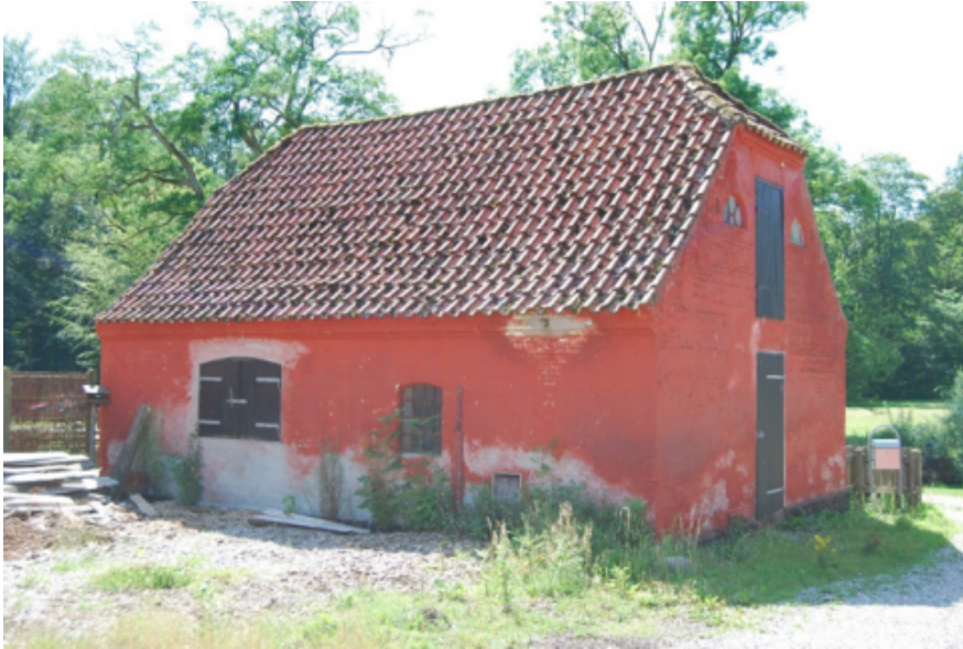
Bygning 15. Foto fra 2019.
