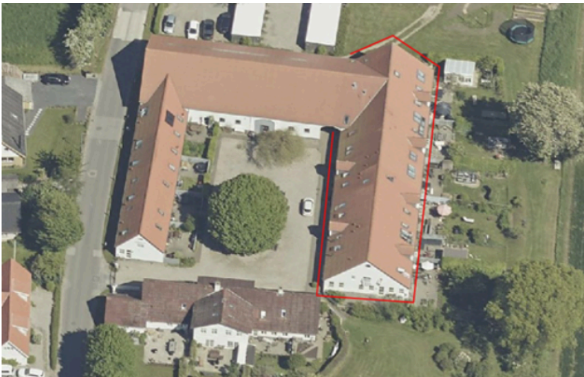
Skråfoto, som viser Gl. Bjert 60 (Bjertgård). Den røde markering viser, hvor planlægningen vil give mulighed for 3 etager i form af en udnyttelse af eksisterende spidsloft.
