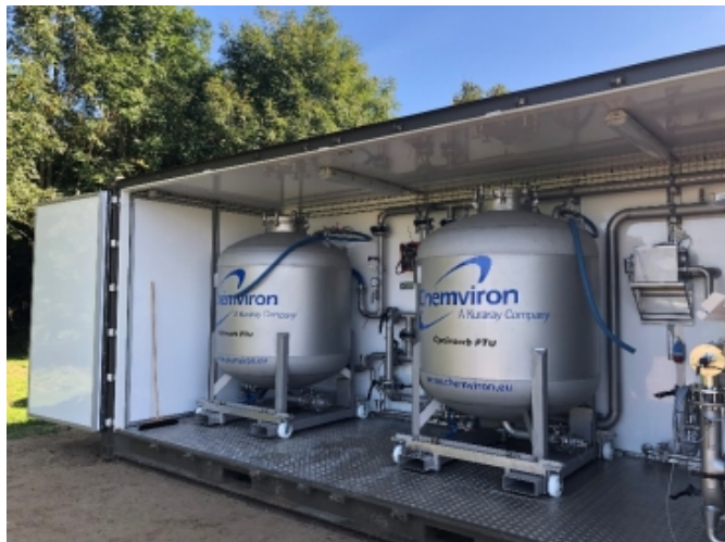
Kulfilteranlæg
