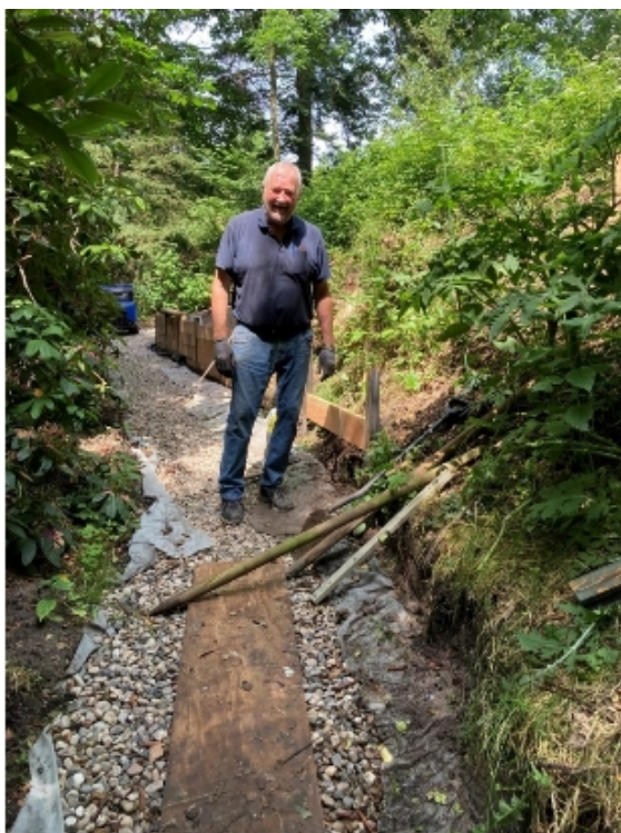
Jens Lauritsen i gang med anlæggelsen af første etape 2021.
