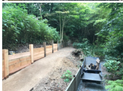
Jens Lauritsen i gang med anlæggelsen af første etape 2021.
