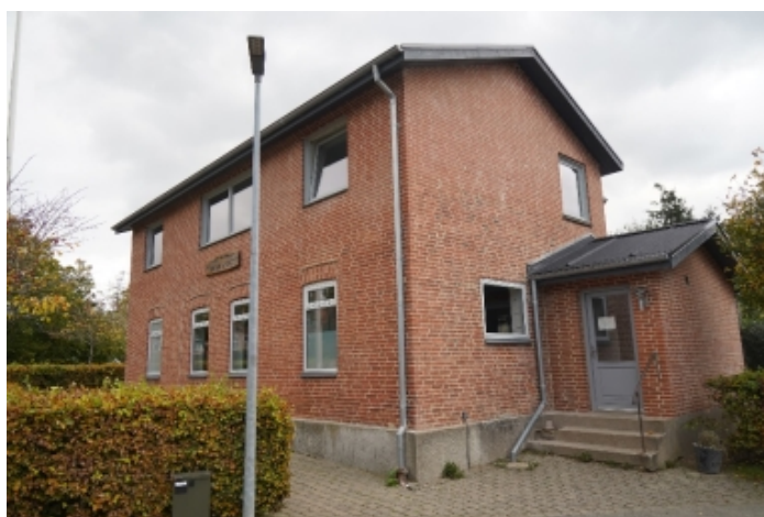
Facaderenovering af Sdr. Stenderup forsamlingshus "Dannevirke" efter.
