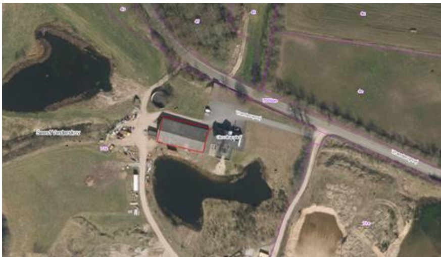
Bebyggelse på Vranderupvej 57. Eksisterende 600 m 2 hal markeret med rød vest for eksisterende stuehus.
