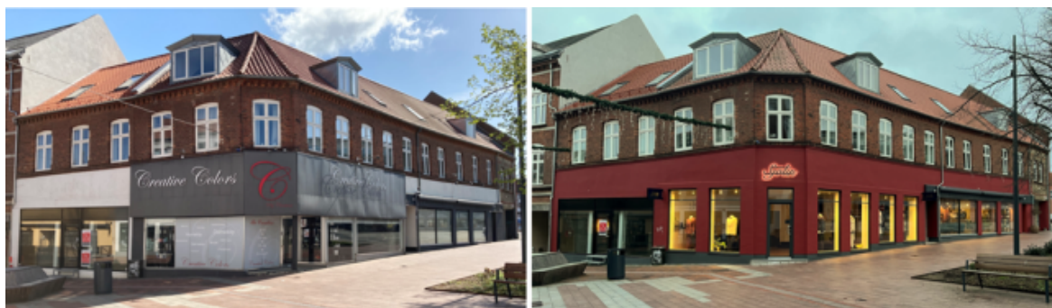
Før-og efter foto af byejendommen Søndergade 29-35, Kolding fik puljestøtte til facaderenovering i 2022.
