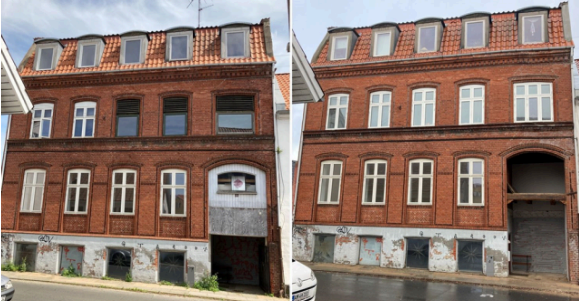
Før-og-efter-foto Ejendommen Blæsbjerggade 6, Kolding fik puljestøtte til vinduer og facaderenovering i 2023.
