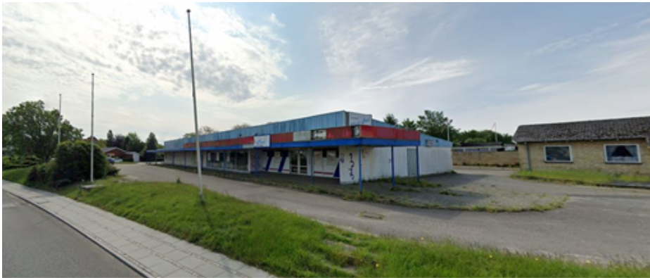
Foto af den tidl. supermarkedsbygning, som nu er nedrevet.
