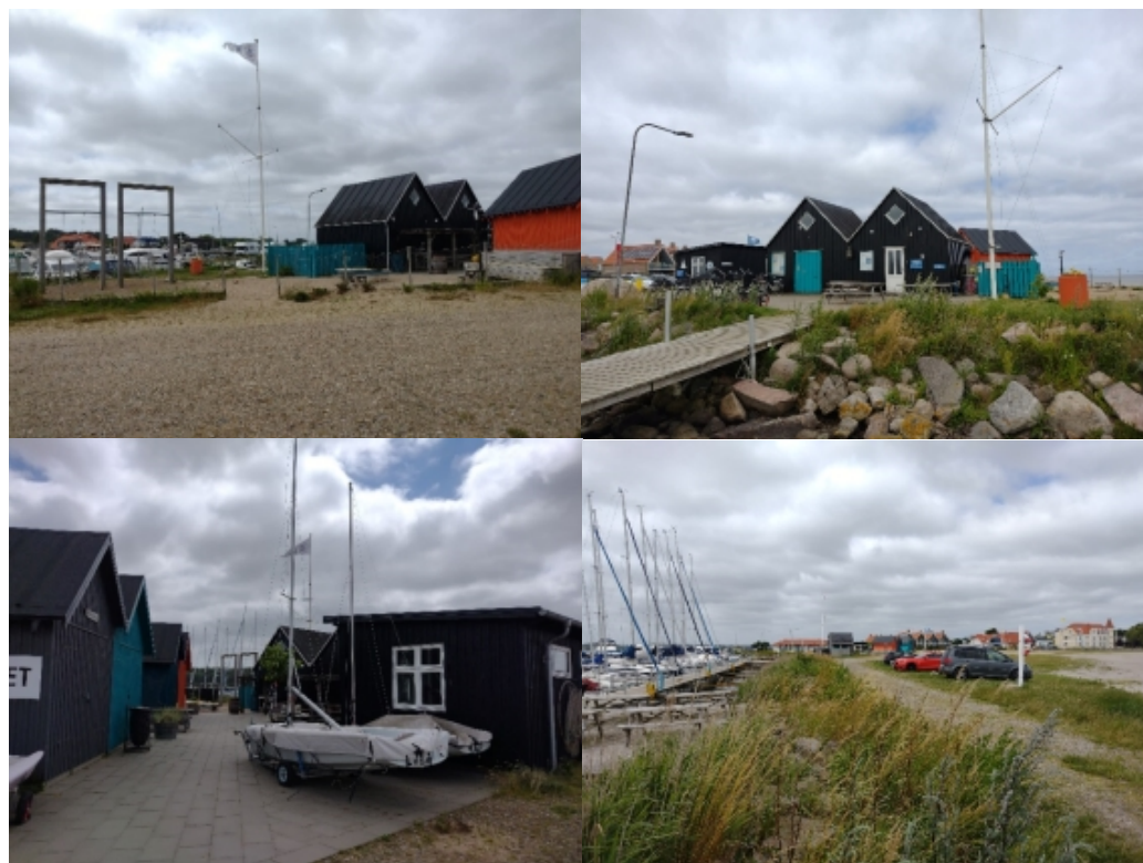
Billeder af forholdene i dag, der viser udbygningen med skure, som er midlertidigt opført på baggrund af en rammesat prøvehandling.
