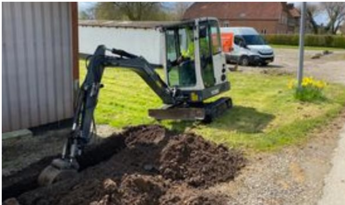
Her ses gravearbejdet i forbindelse med indlæggelse af strøm i huset bag gravemaskinen.
