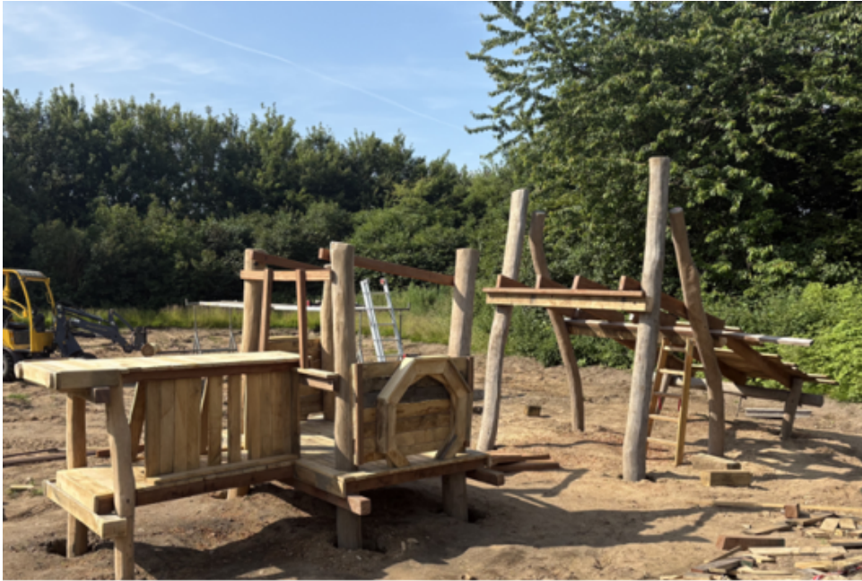
Her ses projektet med legepladsen i byggefasen.
