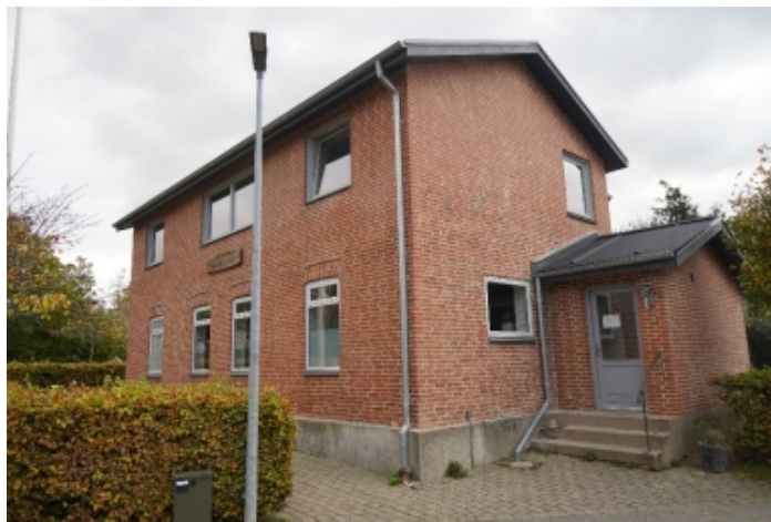
Facaderenovering af Sdr. Stenderup forsamlingshus "Dannevirke" efter.
