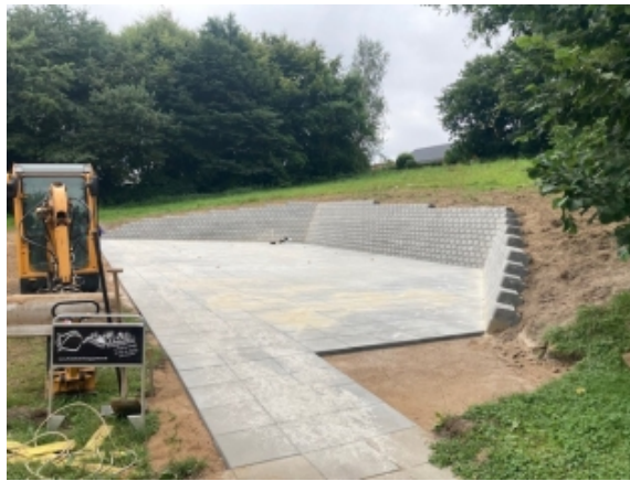
Areal til fælles bålhytte med ny belægning.
