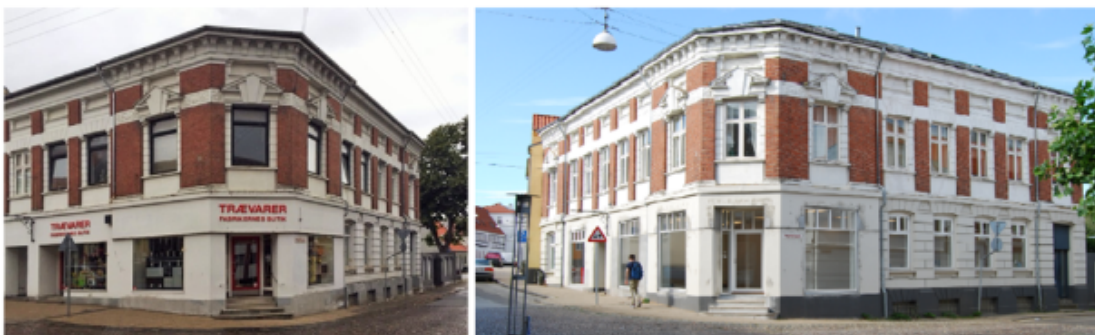
Låsbygade 1a, Kolding fik nye vinduer med puljestøtte i 2018. Siden er stueetagen ombygget.
