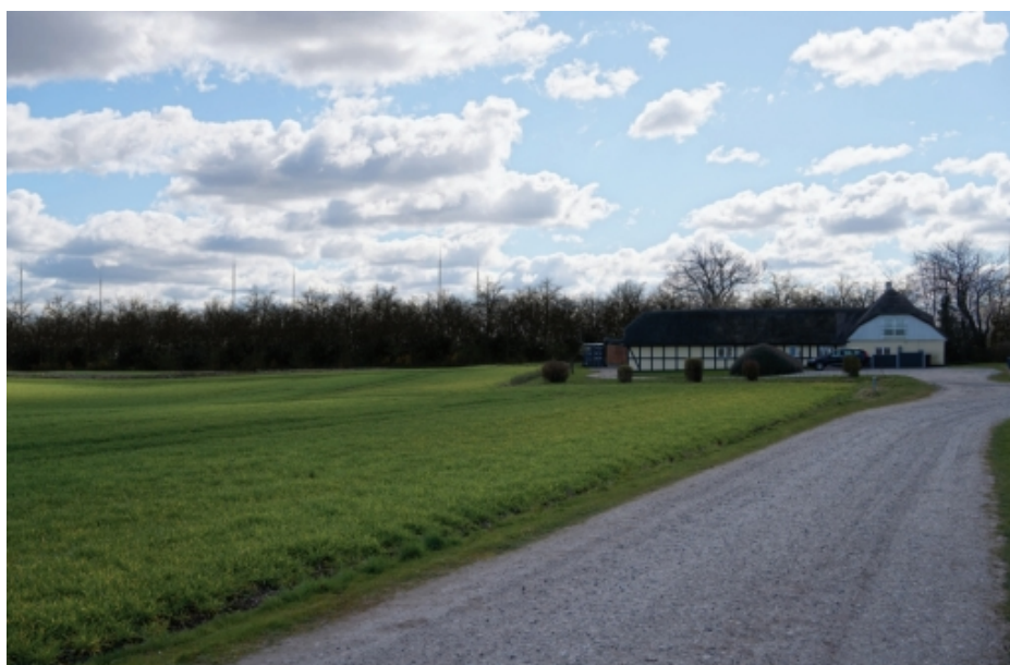
Eksempel på en sammenlignelig Energinet transformerstation med ung (øverst) og opvokset (nederst) beplantning.
