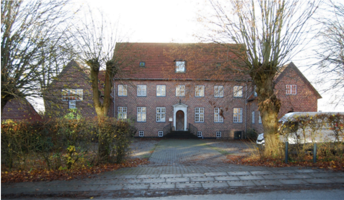
Fuglehøj set fra Dyrehavevej.
