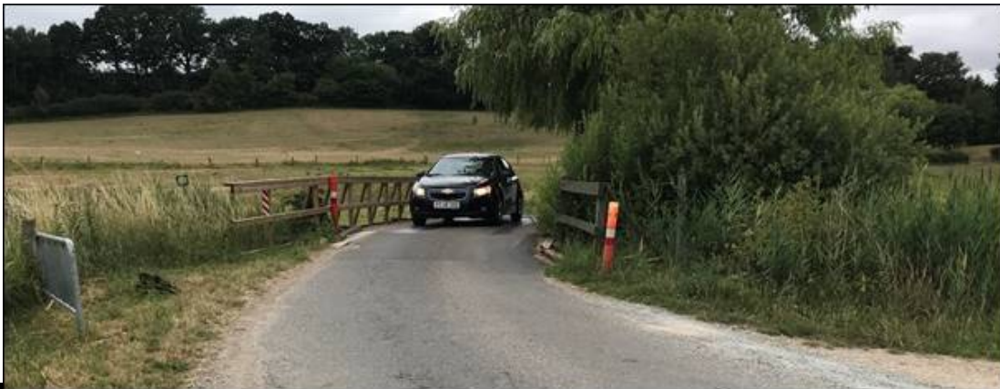
Figur 4. Eksisterende vejbro over Kolding Å.
