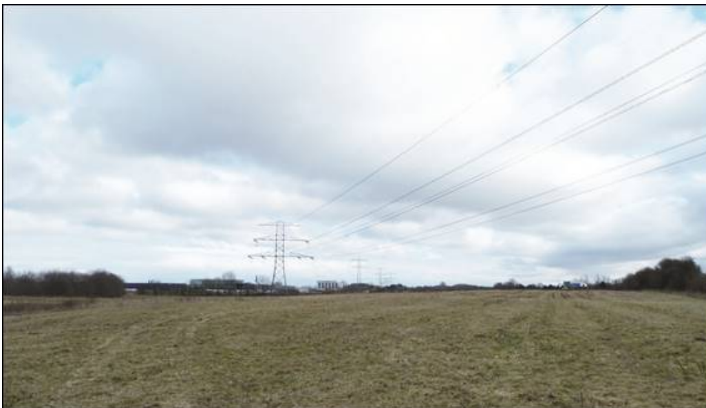
Højspændingsledningen deler området mellem det allerede bebyggede areal i baggrunden til venstre i billedet (Bilhuset P. Christensen) og området til højre billedet, hvor lokalplantillægget åbner mulighed for ny bebyggelse ud mod motorvejen.
