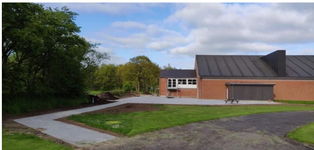
Alminde-Viuf hallens nye belægning på vestsiden af hallen ud mod boldbanerne.
