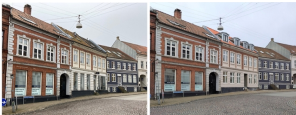
Omdannelsen af stueetagerne i ejendomme i Låsbygade, Kolding til boligformål er i gang. Ejendommen Låsbygade 55 fik byfornyelsesstøtte i 2021.
