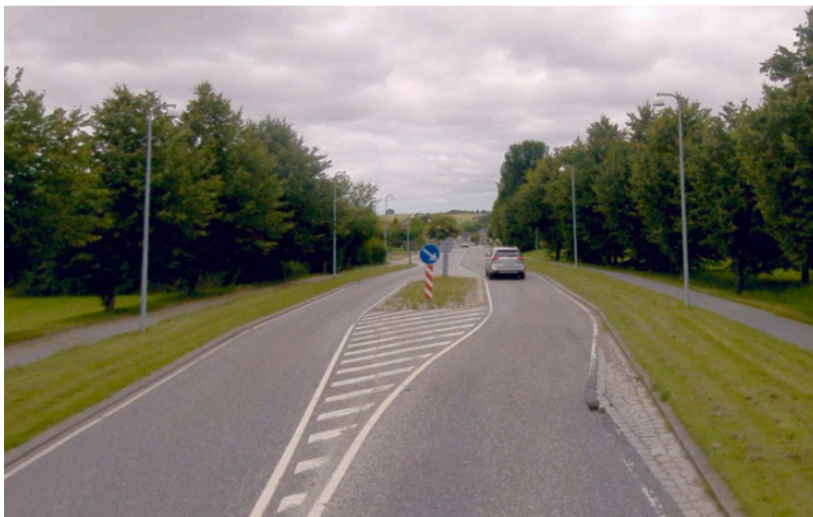
Figur: Koldingvej gennem Ny Højen
